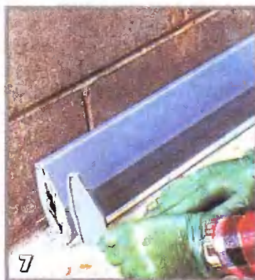
7 Шпателем нанесите клей на торец секции
