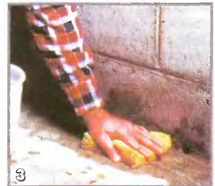
Удалите грязь и пыль, тщательно вымойте пол и дайте ему просохнуть
