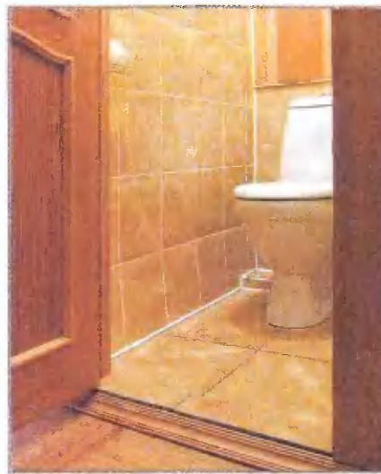
Нижний ряд плитки на стенах я уложил под небольшим углом к полу
