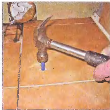
После полного схватывания плиточного клея просверлил в половой плитке отверстия для установки нового унитаза
