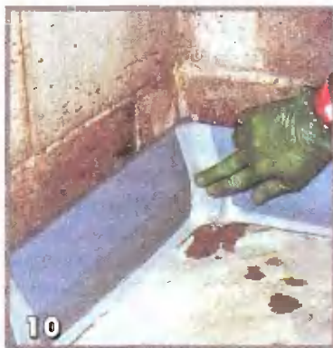
10 Рукой (обязательно в перчатке) удалите излишний клей и в угловых соединениях
