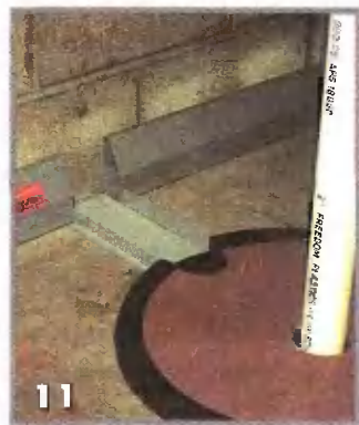
11 Лотком направьте воду в емкость. Регулярно откачивайте воду, не допуская переполнения накопительной емкости
