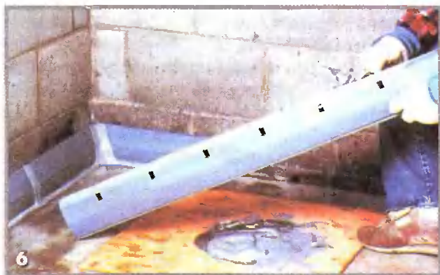
6 Щедро смажьте клеем нижнее ребро секции плинтуса и прижмите его к месту
