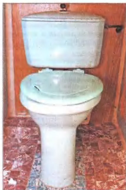
Туалет до ремонта
