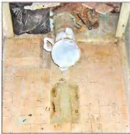
После снятия унитаза вход в канализацию закрыл целлофаном, плотно примотав его скотчем
