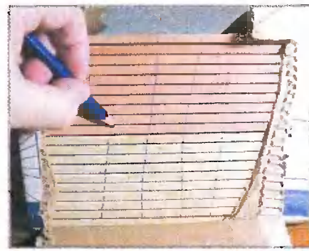
Маркировка торцов плитки карандашом
