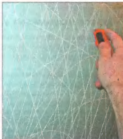
Подготовка покрытых краской стен к отделке кафельной плиткой
