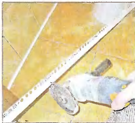
Примыкание половой плитки к стенам оформил пластиковой раскладкой
