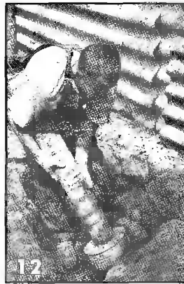
Верхняя часть столба — залитая пескобетонной асбестоцементная труба Ø100 мм. Вес «грибка» с такой ножкой велик — с работой может справиться один человек без использования механизмов
