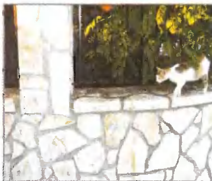
Соорудить каменную стену можно из любых прочных камней, а кладку иногда есть смысл облицовывать пиленным или колотым камнем
