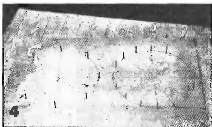
4 Основание опалубки башмака — фанерный лист с набитыми по окружности гвоздиками
