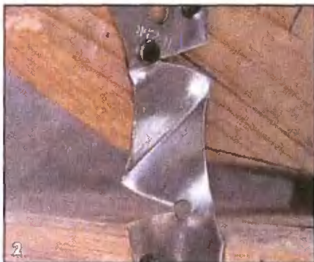
Стропильная стяжка в условиях перегрузки
