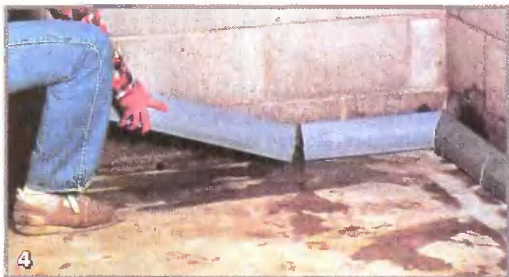
4 Заранее отпилите пластмассовые детали водосборной системы нужной длины и конфигурации («на ус» для внутренних и внешних углов)
