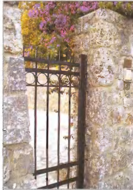
При строительстве ворот и оборудовании входа и въезда-выезда с улицы необходимо не нарушать водостока. На дно дренажной канавы закладывают металлическую, асбоцементную или бетонную трубу, а въездную площадку делают с твердым покрытием
