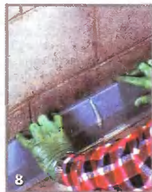
8 Состыкуйте плинтусы и удалите излишки клея
