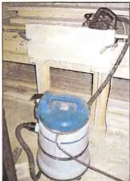
Простые опоры позволяют обрабатывать рубанком кромки панелей
