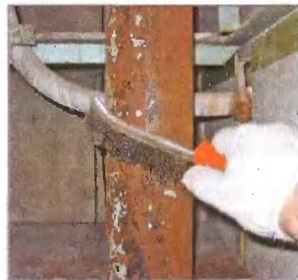
Остатки старой краски с труб счистил металлической щеткой
